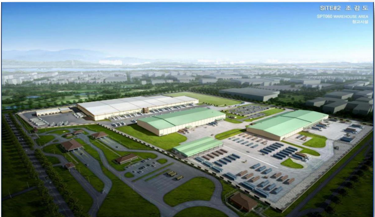
창고시설 등 2개시설 건설공사(시공) 전기소방공사 2공구 ₩14,046,192,416
