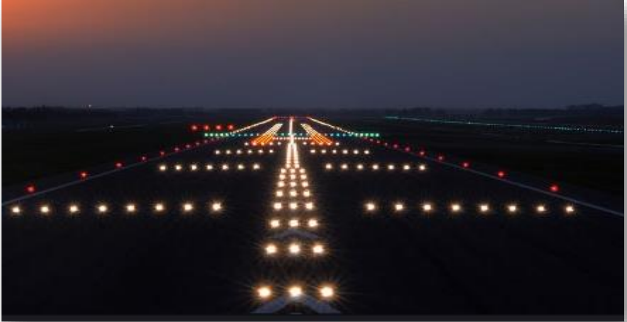
평택 대미 주활주로 포장공사 / 전기공사 ₩13,702,612,516
