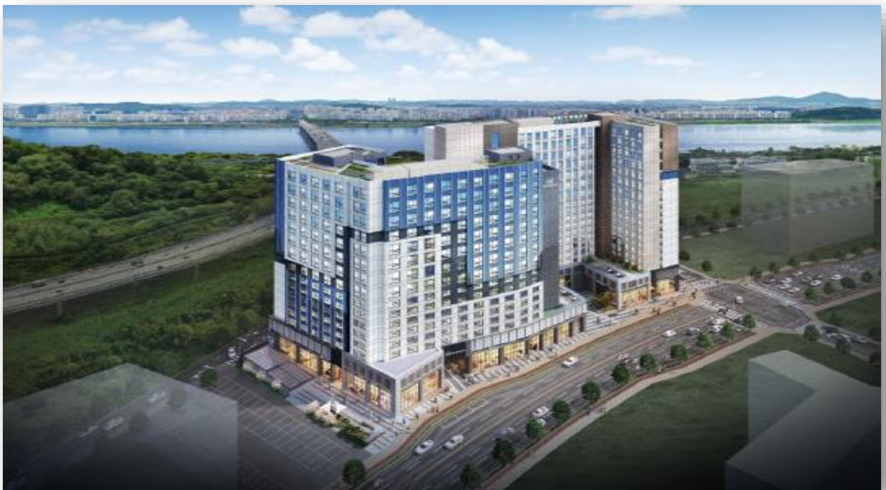
고양시 덕은지구 복합시설 신축공사/가설공사 ₩ 4,268,000,000
