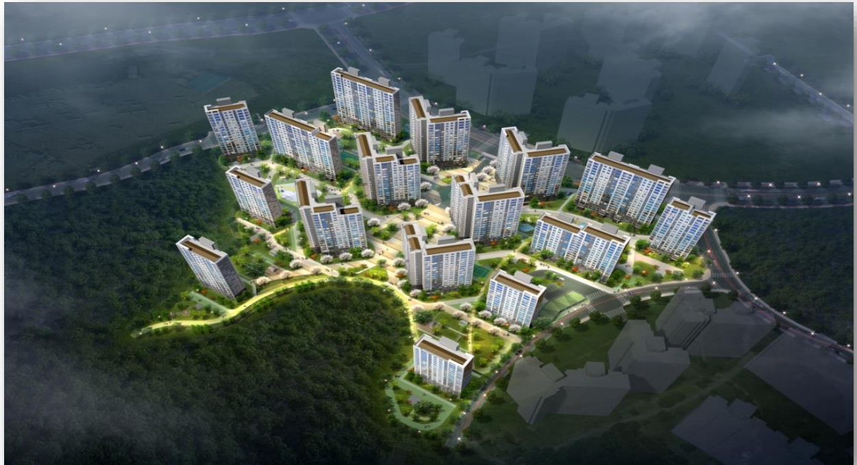
경기 고양 향동지구 B-1블록 전기공사 2공구 ₩1,925,006,000
